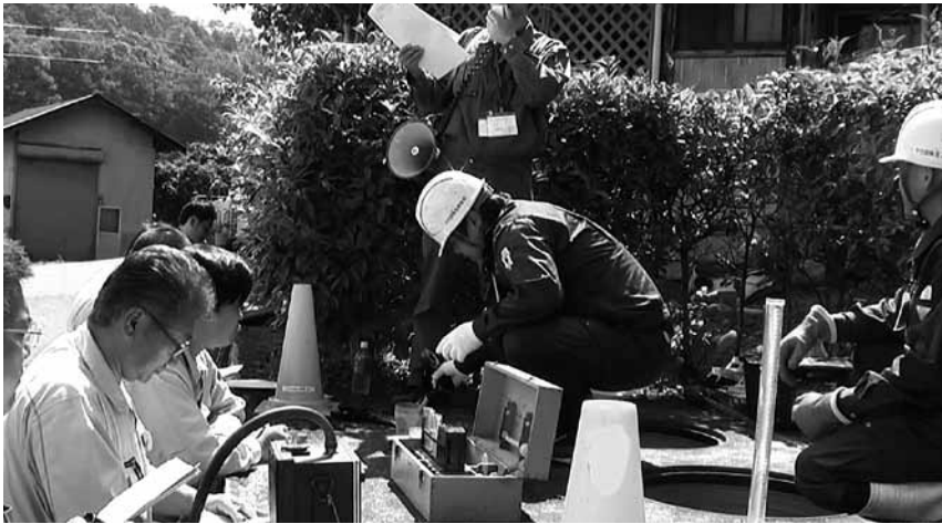
保守点検及び清掃作業手順の説明
